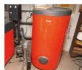
Warmwasserspeicher
